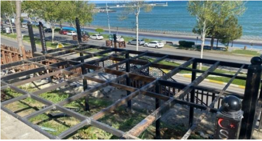
Tuna Boyu Seyir Terası Yapımı
