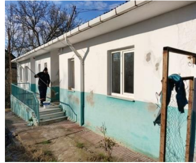
Ahmetçe Mahallesi Muhtarlık Binası Boya çalışması
