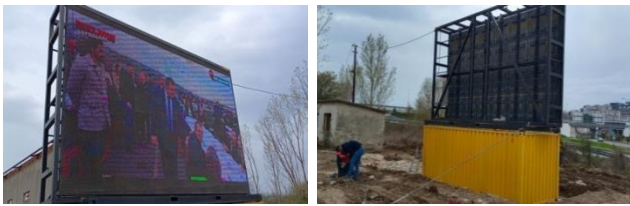
Değirmenaltı Mahallesi Led ekran kurulumu
