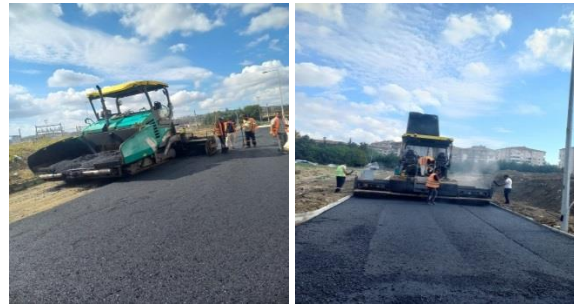
100. Yıl Mahallesi Vedat Sokak
