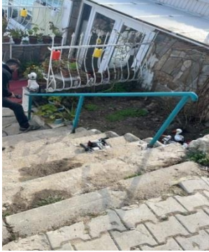
Korkuluk Yapımı ve Tamiri
