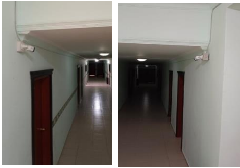
Kumbağ otel güvenlik kamerası montajı
