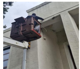
Ajans Binası Elektrik Tadilatı
